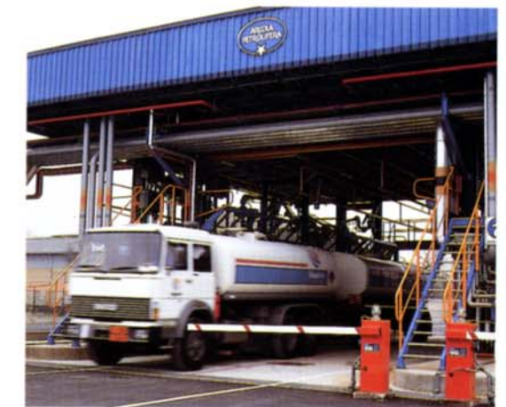
Dopo circa 25 minuti il carico dell'autocisterna è completato.
